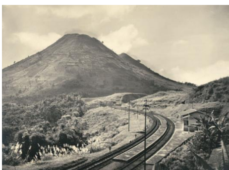
Gambar 11: Pemandangan indah di stasiun Lebak Rejo
