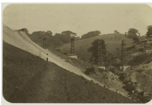
Gambar 1: Proses Pembangunan Jembatan
